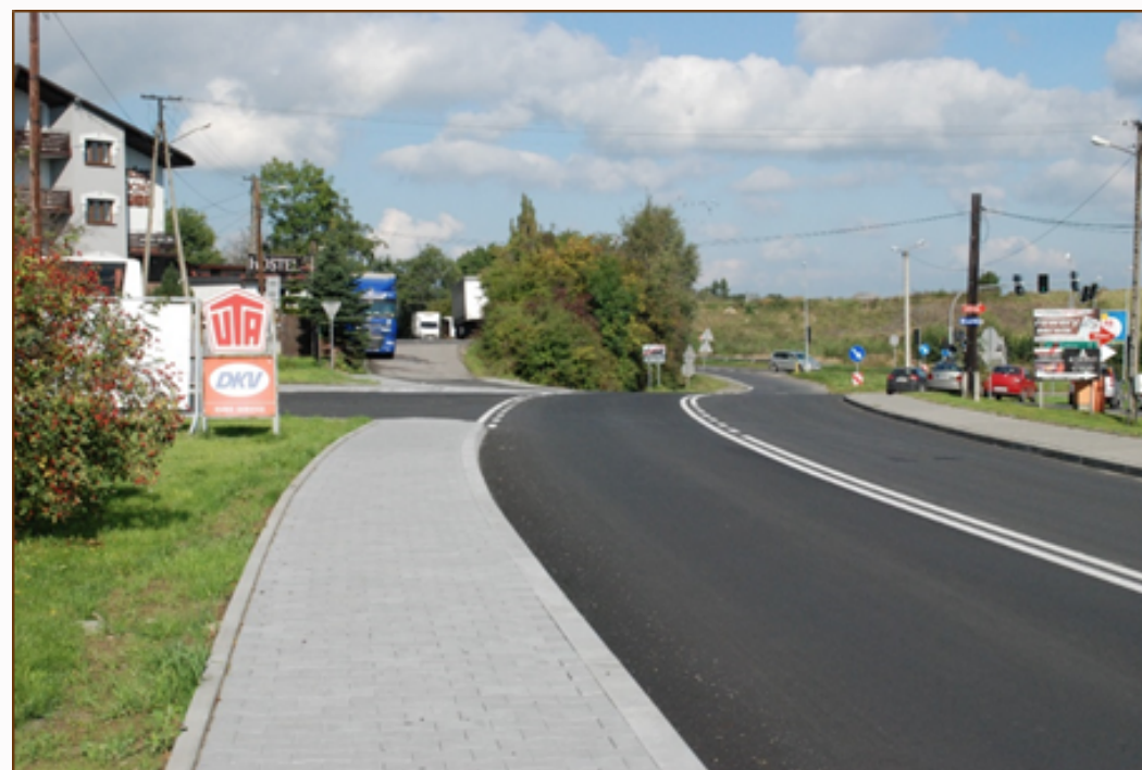
PRZEBUDOWANA DROGA POWIATOWA UL. SOBIESKIEGO W MYŚLENICACH
