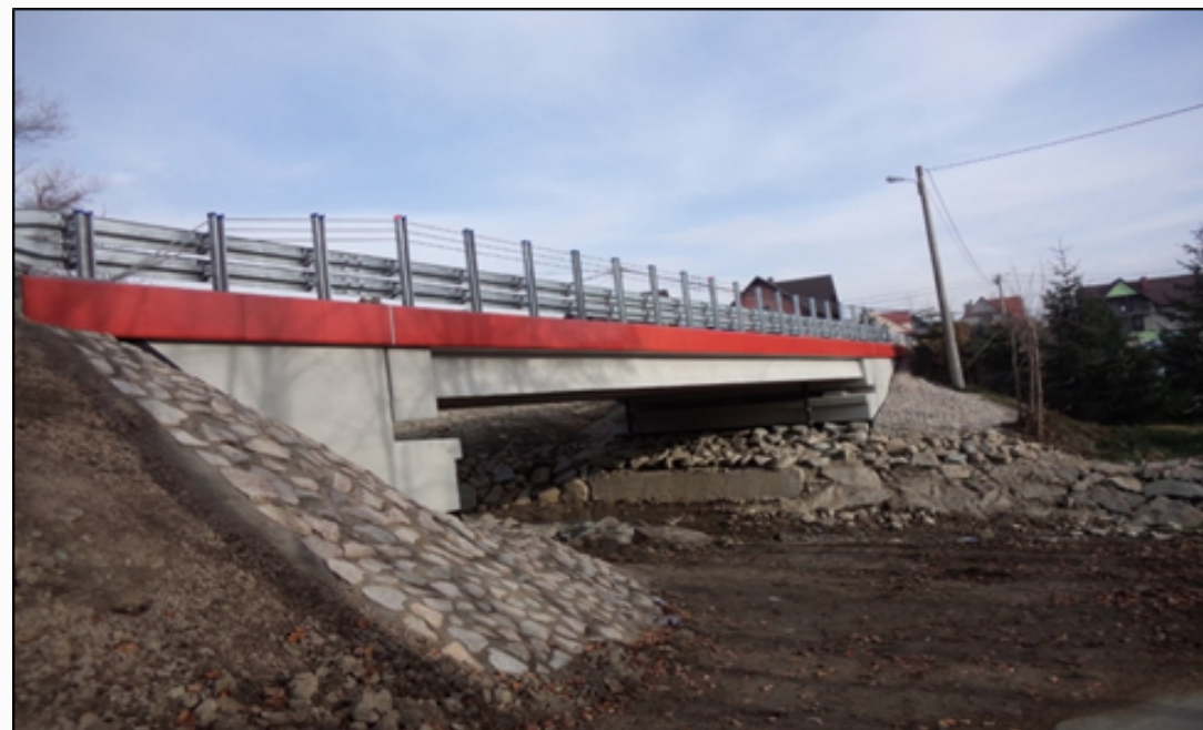
PRZEBUDOWANY MOST W CIĄGU DROGI POWIATOWEJ PCIM -TOKARNIA - JORDANÓW
