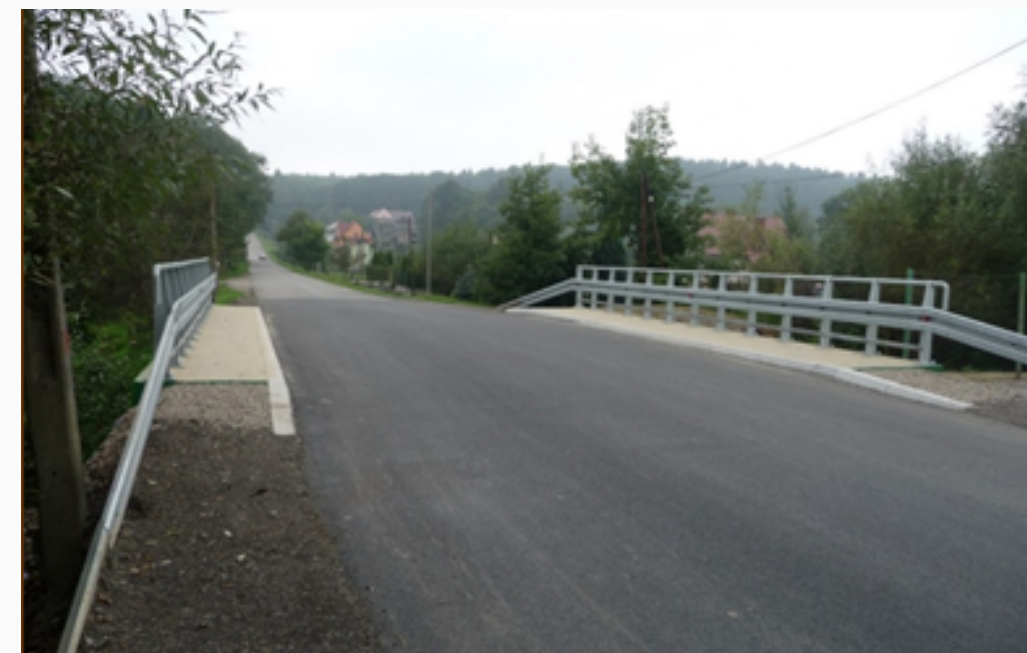
WYREMONTOWANY MOST NA POTOKU W SUŁKOWICACH W CIĄGU DROGI POWIATOWEJ - UL. PTASZNICA
