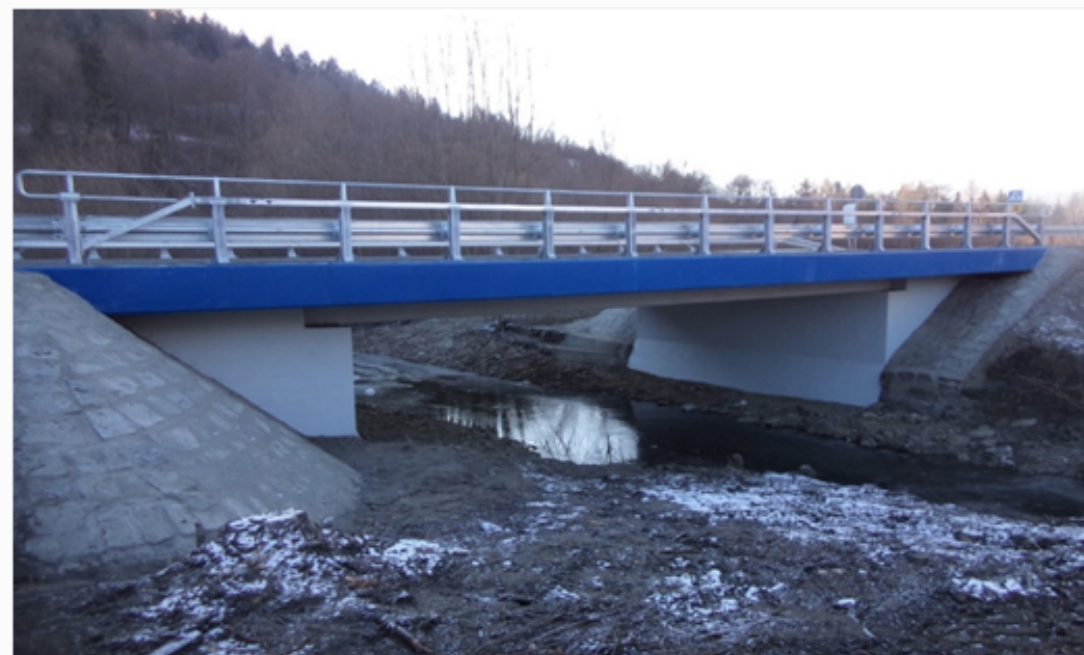
PRZEBUDOWANY MOST W CIĄGU DROGI POWIATOWEJ W TOKARNI (CENTRUM)
