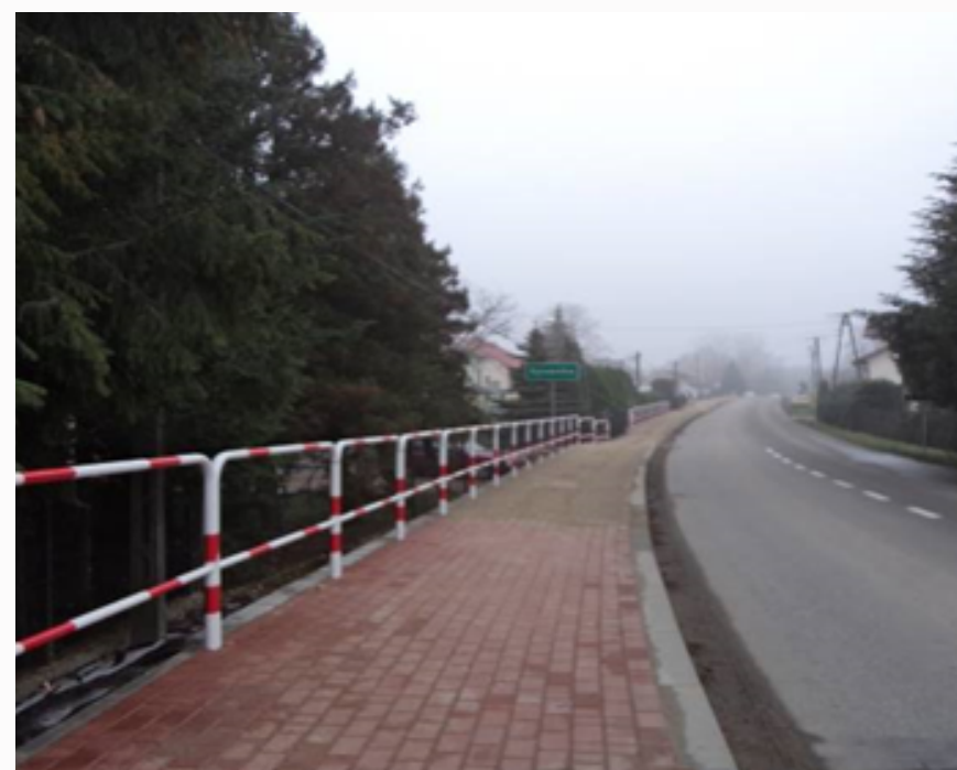
WYBUDOWANY CHODNIK W SIEPRAWIU
