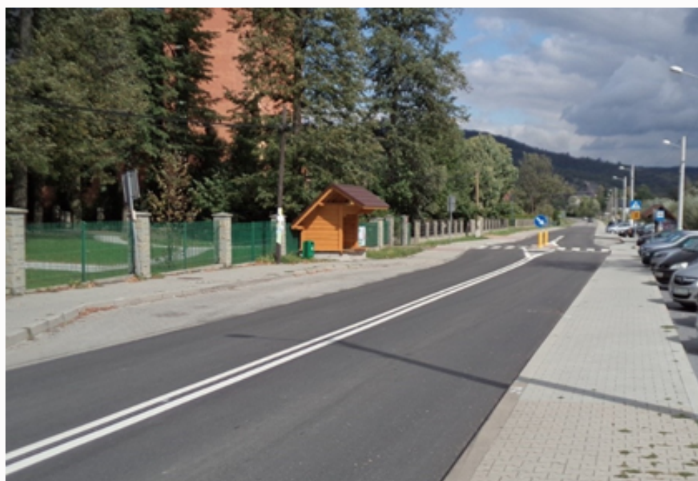
WYREMONTOWANY CHODNIK PRZY DRODZE POWIATOWEJ W TOKARNI
