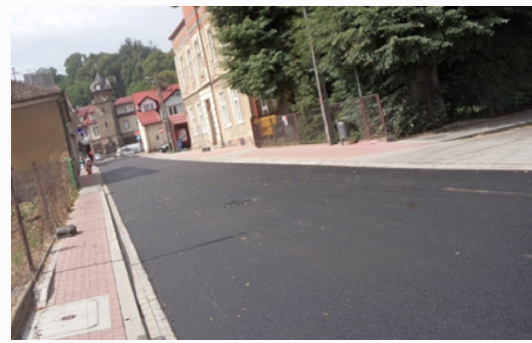
WYREMONTOWANA DROGA POWIATOWA UL. JAGIELLOŃSKA W DOBCZYCACH
