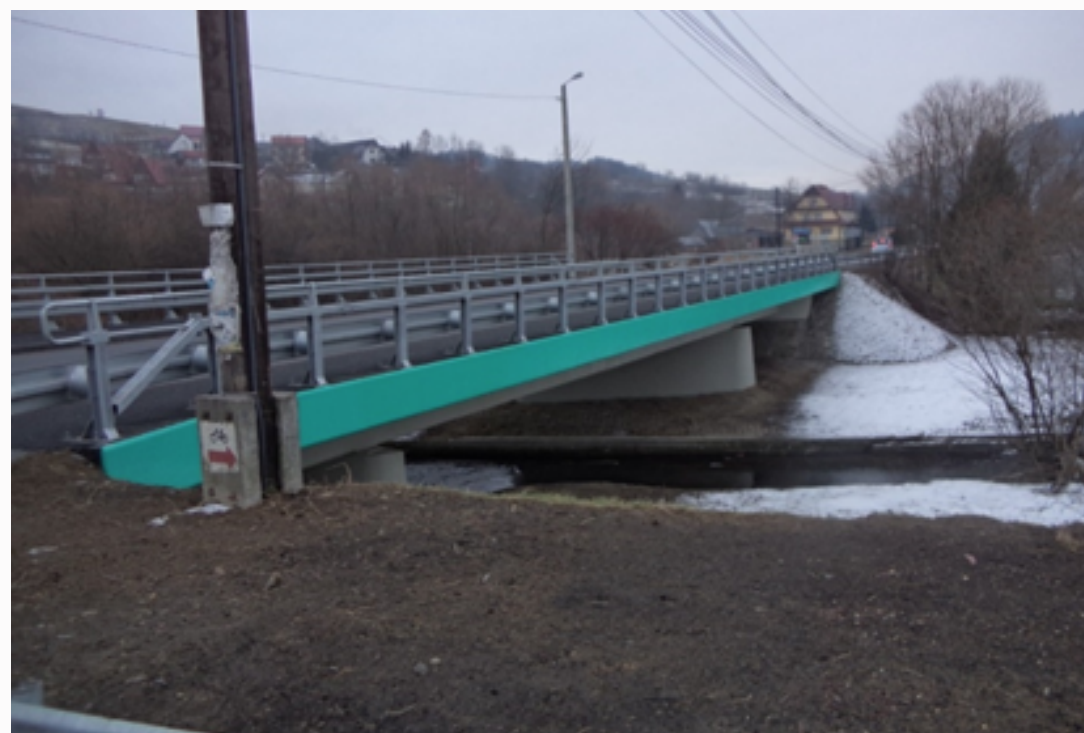
PRZEBUDOWANY MOST W CIĄGU DROGI POWIATOWEJ W TOKARNI (GĘBKI)
