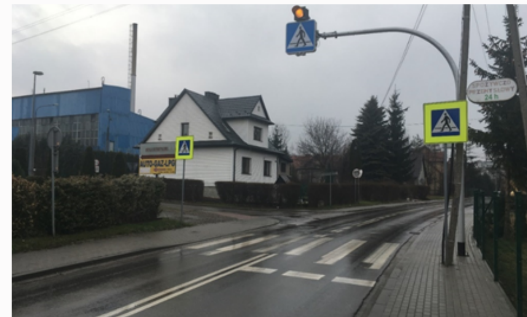
PRZEJŚCIE DLA PIESZYCH W CIĄGU DROGI POWIATOWEJ - UL. 3-GO MAJA W MYŚLENICACH
