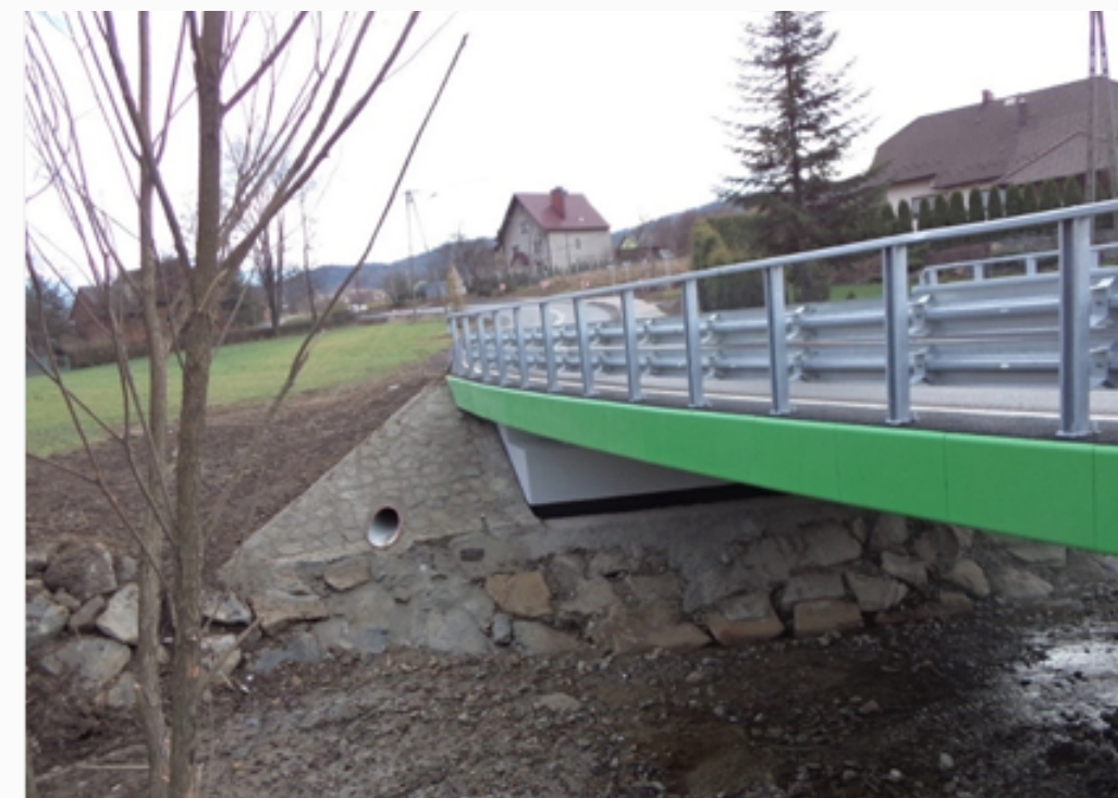
ZMODERNIZOWANY MOST W JASIENICY
