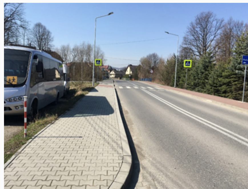
WYREMONTOWANY CHODNIK ULICA SPORTOWA W SUŁKOWICACH
