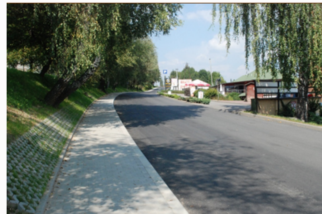
ZMODERNIZOWANA DROGA POWIATOWA UL. KASPROWICZA W MYŚLENICACH
