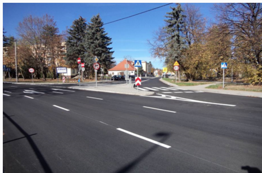
MODERNIZACJA SKRZYŻOWANIA ULIC ŻEROMSKIEGO - SŁOWACKIEGO W MYŚLENICACH
