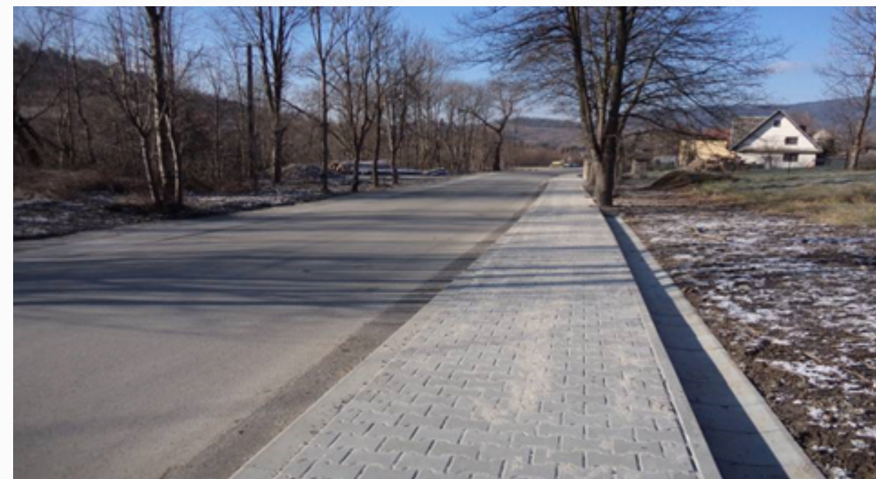
WYBUDOWANY CHODNIK W TENCZYNIE
