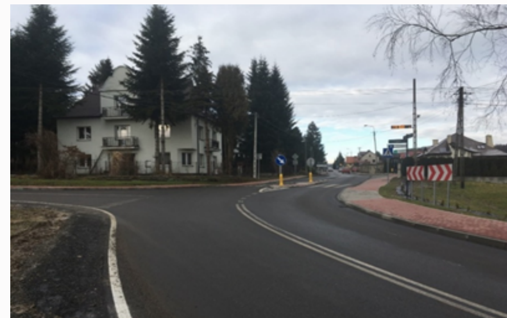
PRZEBUDOWANA DROGA POWIATOWA W SIEPRAWIU
