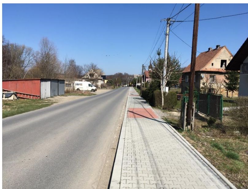
wyremontowanyt chodnik przy drodze powiatowej w Trzemeśni
