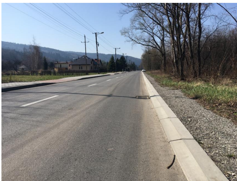
rozbudowany krawężnik na ul. Zdrojowej w Myślenicach
