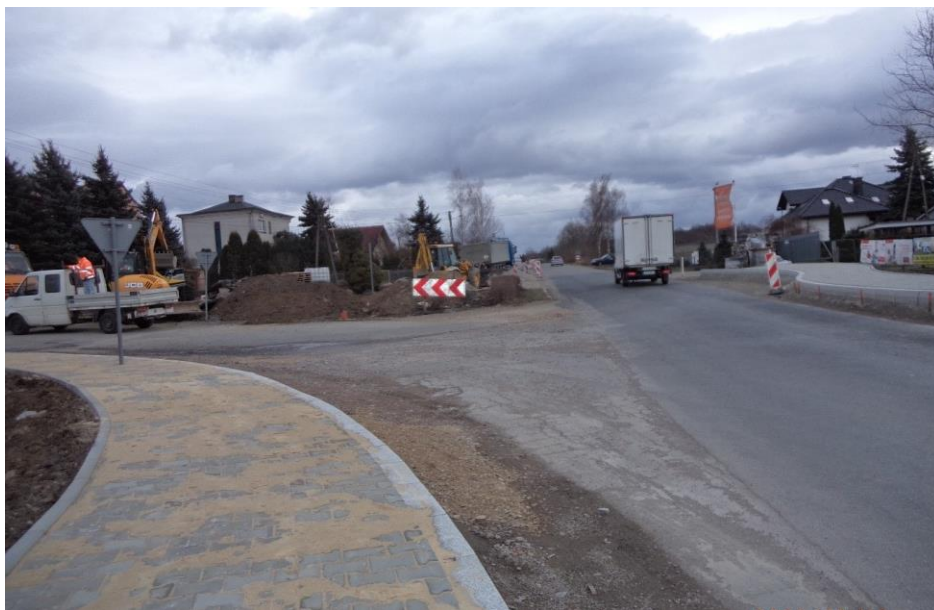
przebudowa dróg i skrzyżowania w Krzywaczce
