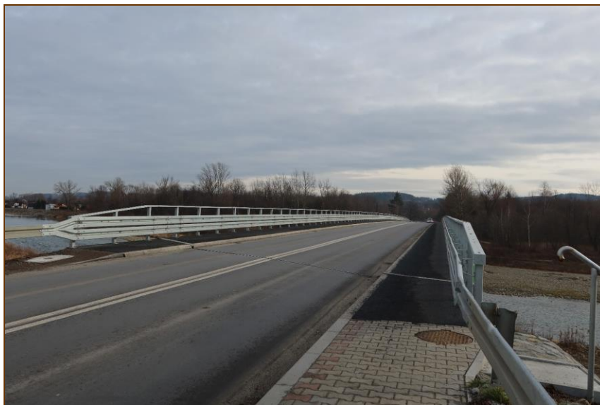
most w Osieczanach po modernizacji
