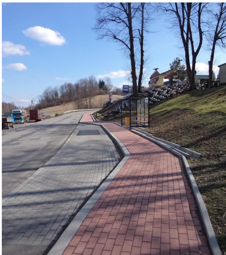
wykonany chodnik w Sieprawiu
