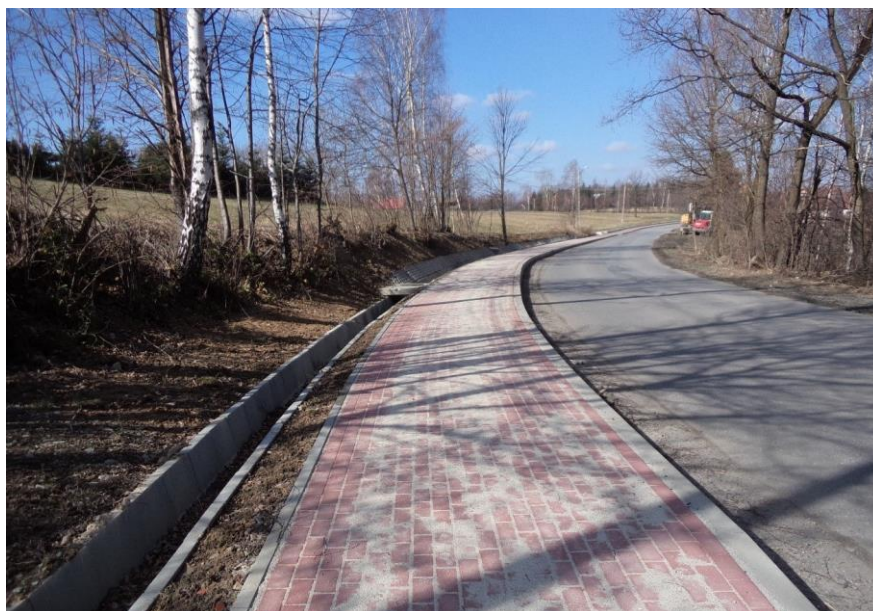
przebudowana droga i wykonany chodnik w Sieprawiu
