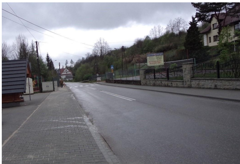
wyremontowana zatoka przystankowa przy drodze powiatowej w Pcimiu
