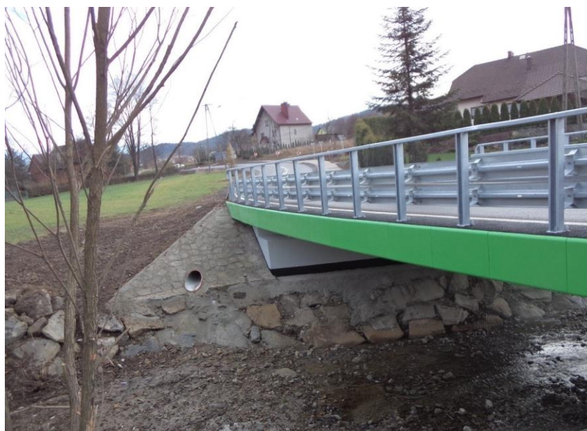
zmodernizowany most w Jasienicy
