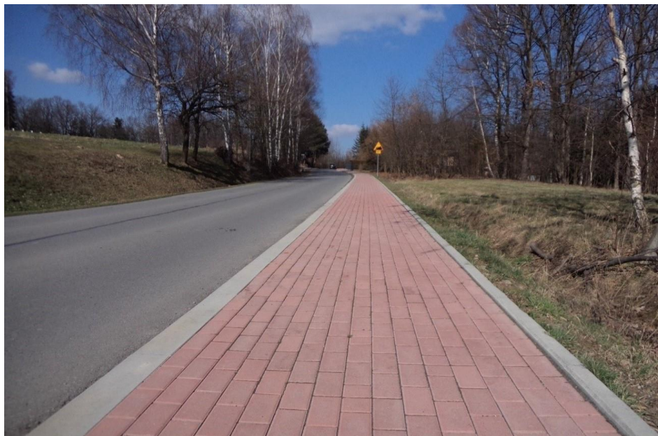
wykonany chodnik w Sieprawiu
