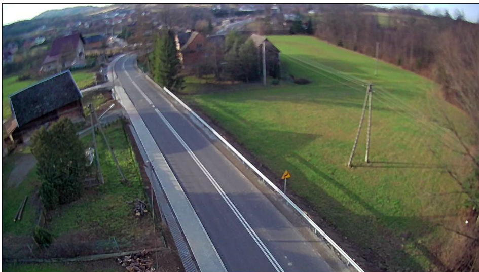
przebudowana droga powiatowa w Jasienicy
