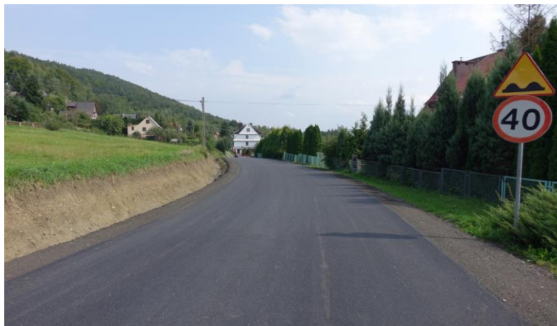
zmodernizowana droga powiatowa w Wierzbanowej
