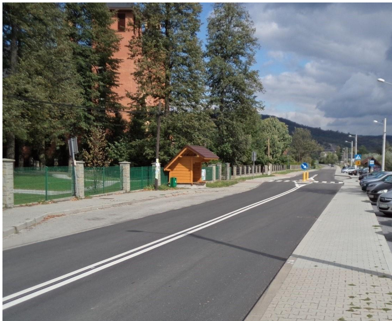
wyremontowany chodnik przy drodze powiatowej w Tokarni
