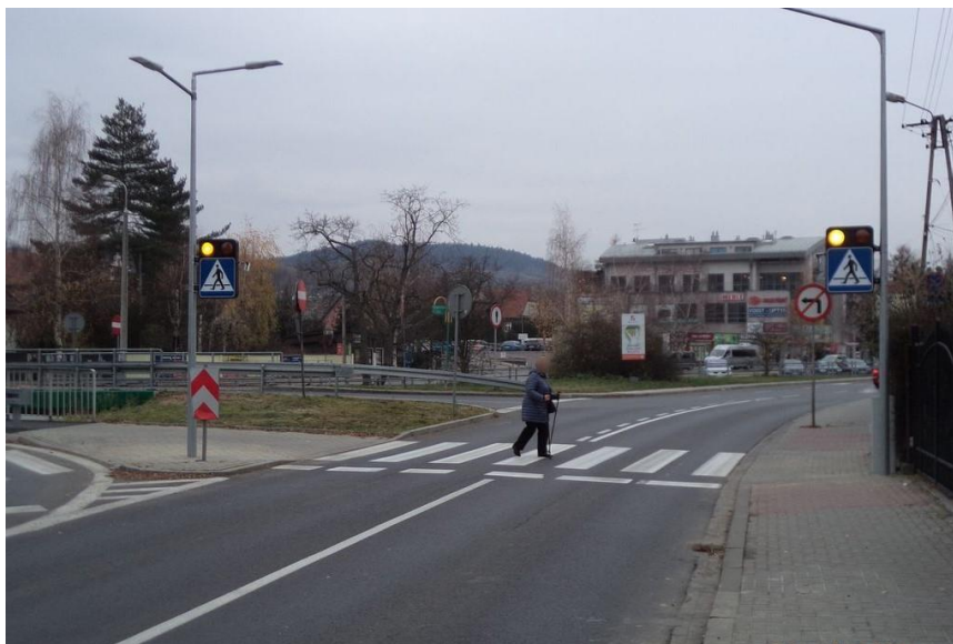
doświetlenie przejścia dla pieszych na ul. Słowackiego w Myślenicach
