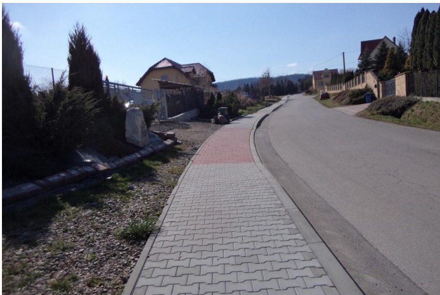
wykonany chodnik w Krzywaczce
