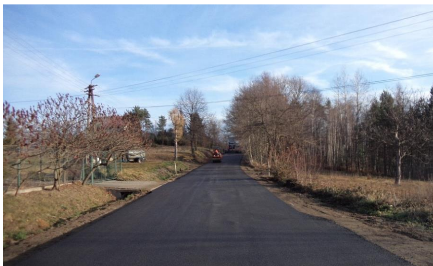
zmodernizowana droga powiatowa w Kornatce
