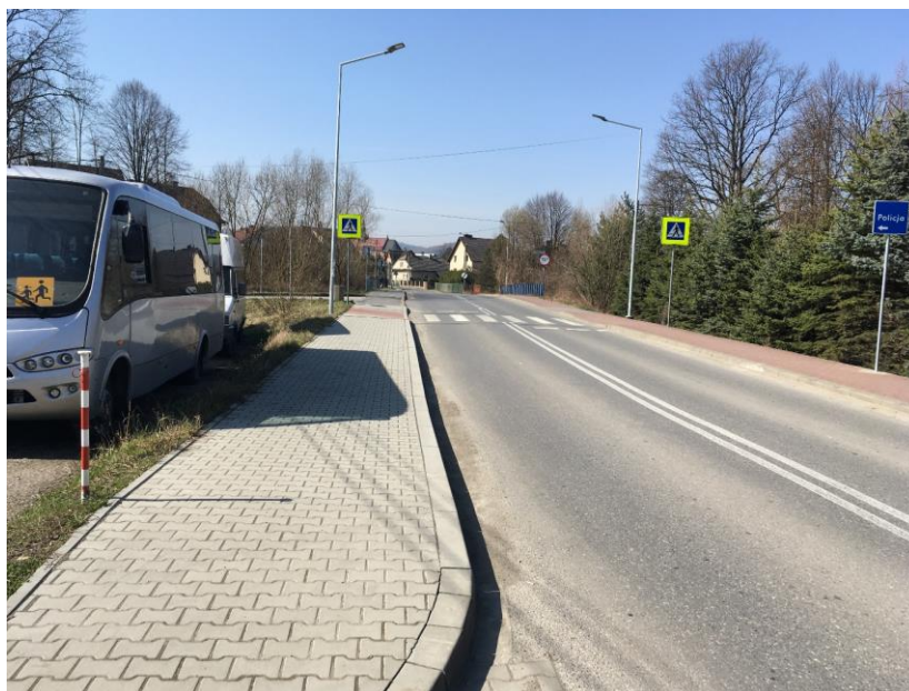
wyremontowany chodnik w ciągu ulicy Sportowej w Sułkowicach
