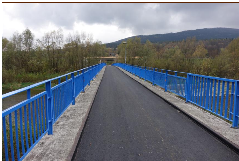
wyremontowany most w Stróż
