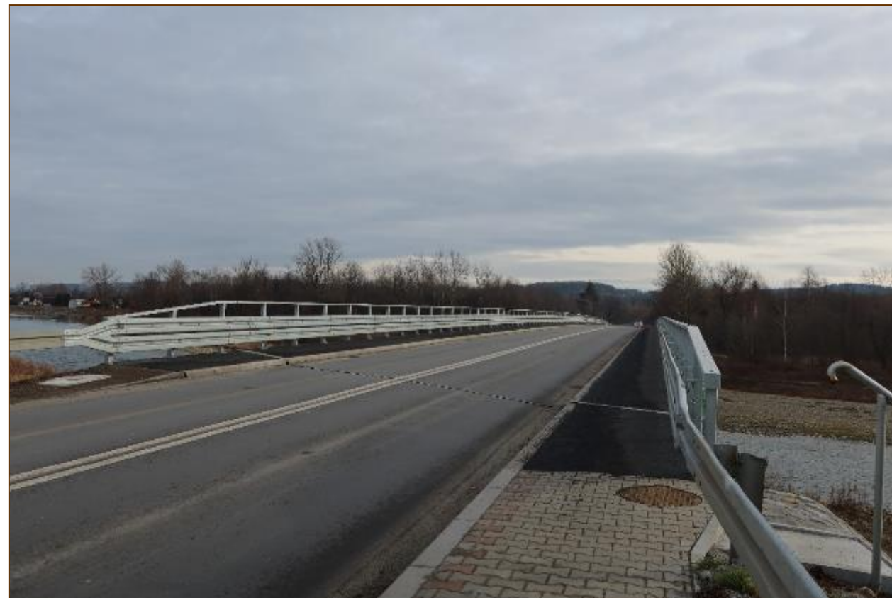
most w Osieczanach po modernizacji
