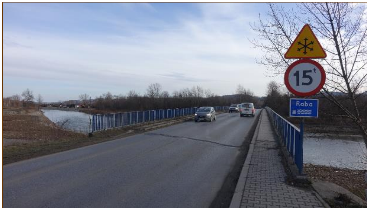
most w Osieczanach przed modernizacją
