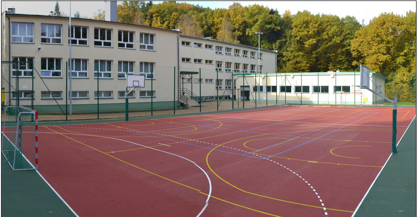
Boisko wielofunkcyjne o nawierzchni poliuretanowej przy Zespole Szkół Zawodowych i Ogólnokształcących w Sułkowicach
