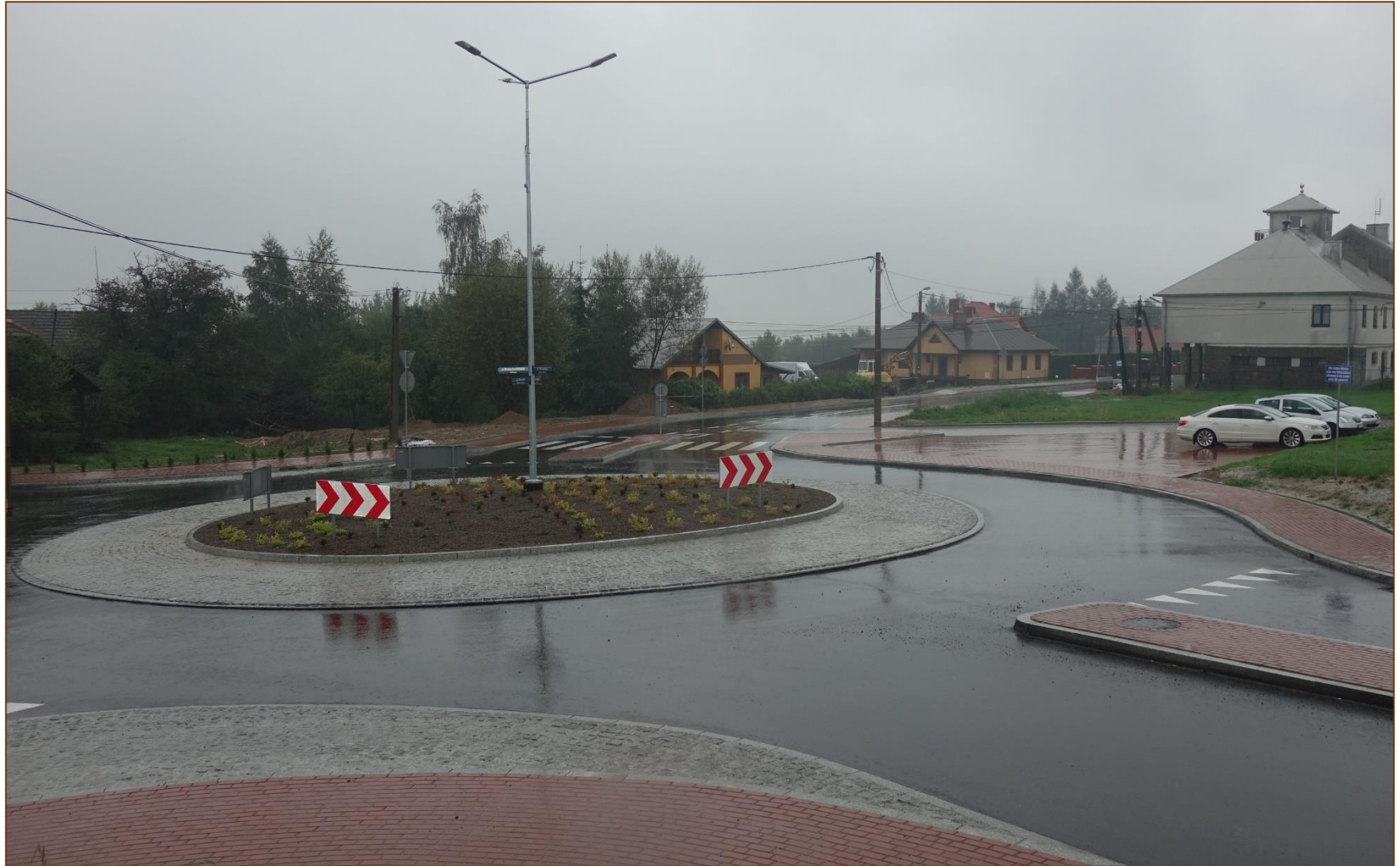
Rondo w miejscowości Zakliczyn (gmina Siepraw) (w ramach inwestycji: Przebudowa drogi powiatowej Siepraw - Zakliczyn - Brzączowice wraz ze skrzyżowaniem z drogą Borzęta - Gorzków - Wieliczka i budową ronda w Zakliczynie)
