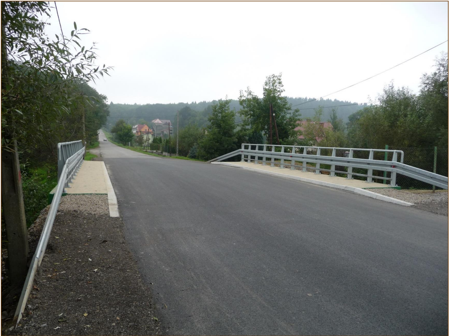
Remont mostu na potoku w Sułkowicach w ciągu drogi powiatowej - ul. Ptasznica
