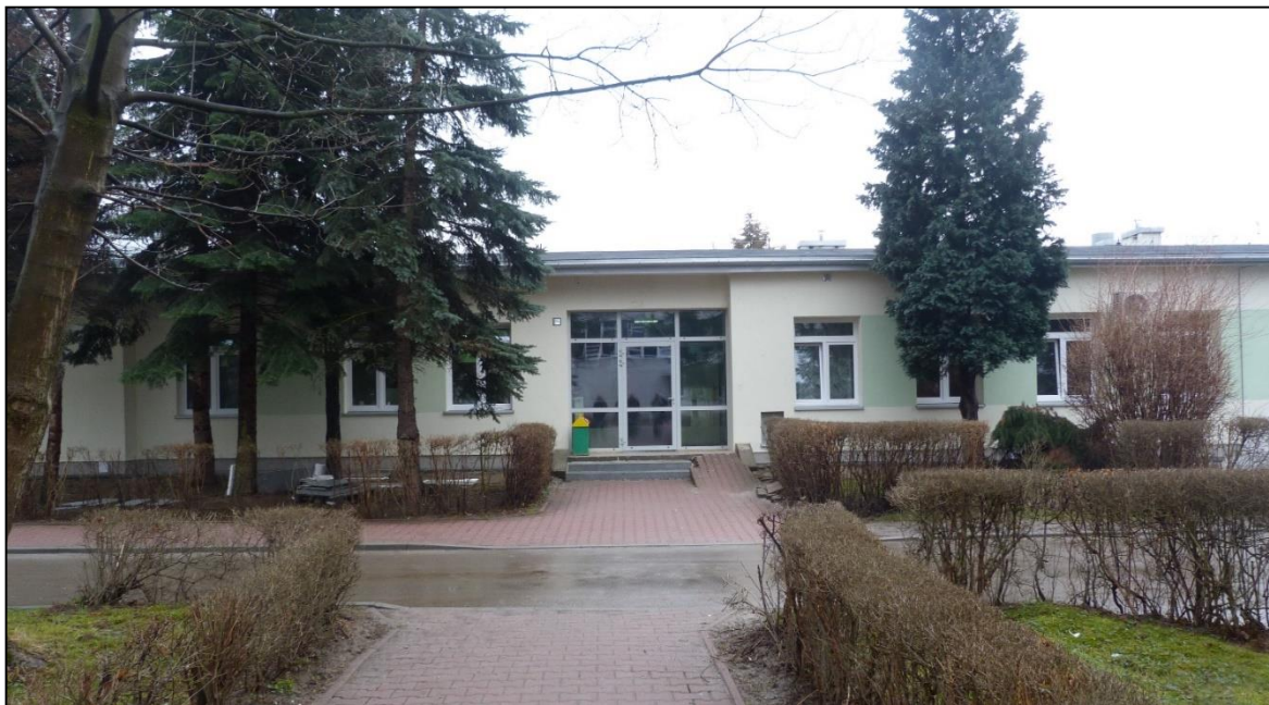
Termomodernizacja budynku przychodni SP ZOZ w Myślenicach
