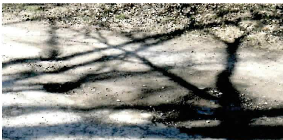
Fot. 10 Fotografia obecnego stanu nawierzchni drogi K1931 z dn. 30.03.2019 r.
